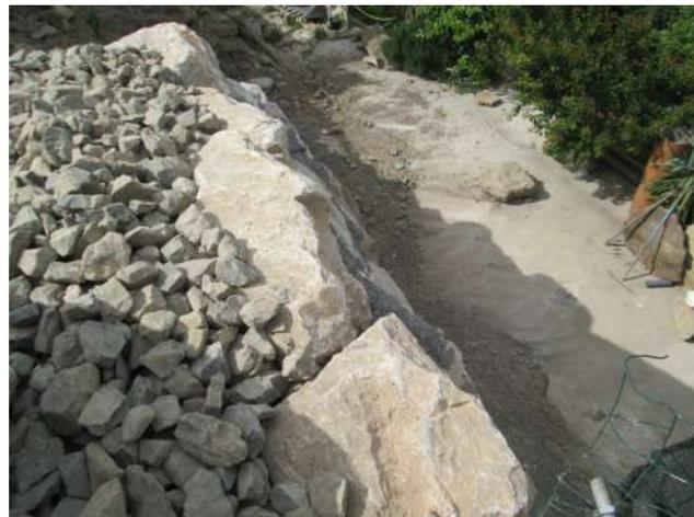
Suite à un appel d'offres remporté par l'entreprise Burgat, le renforcement du chemin communal en contrebas de la rue a pu être réalisé : enrochement en allant chercher la roche mère, dans l'alignement existant et drainage. Pour ce faire, le mur de la Garenne a été détruit, puis reposé avec son garde-barrière.
